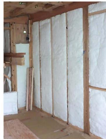
写真 4.2.1 外壁の断熱施工
